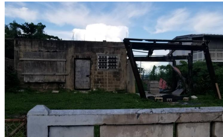
写真6 屋根が飛ばされ、廃墟と化した住宅が散見された👉
